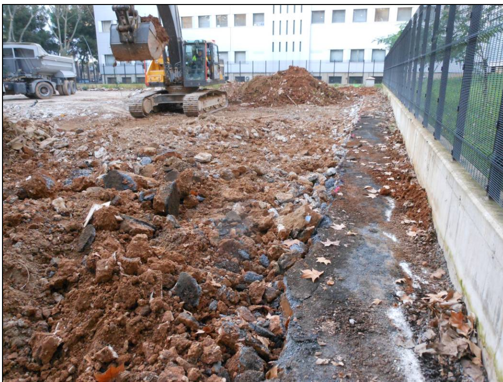
Foto 5: Inici de l'excavació al solar. Eliminació de la capa de formigó existent.
