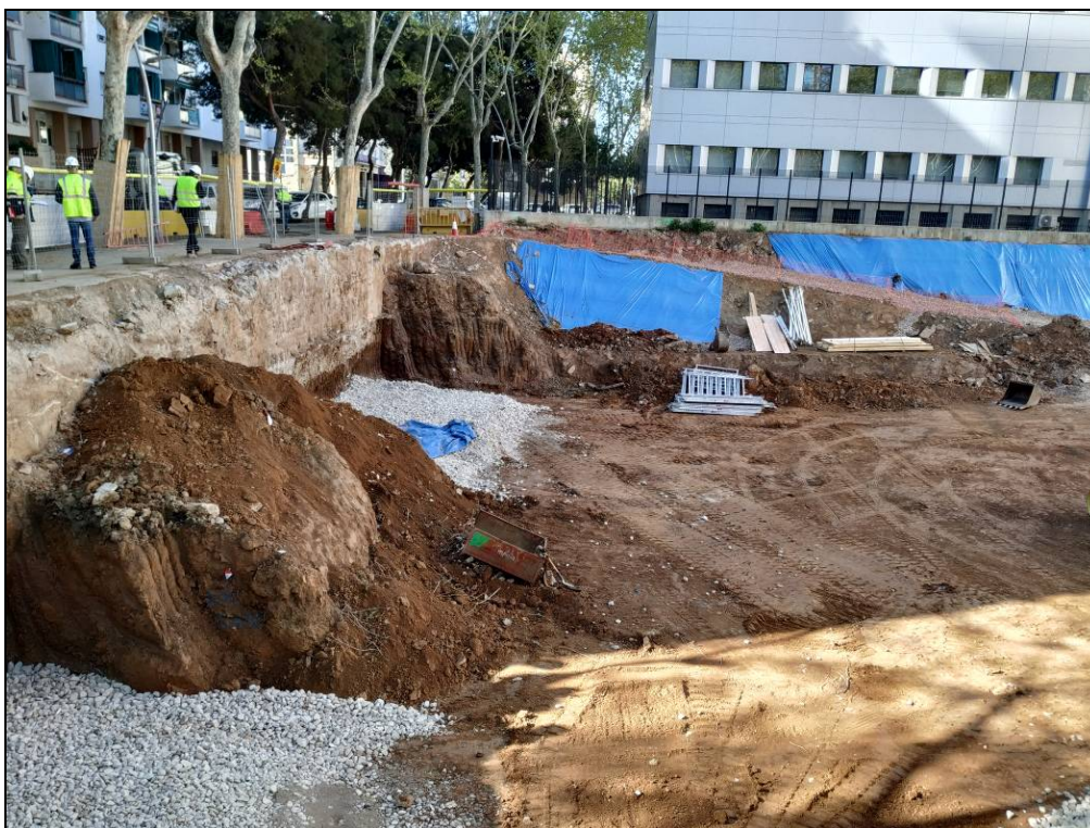
Foto 41: Construcció de betatges al sector del carrer del Treball.
