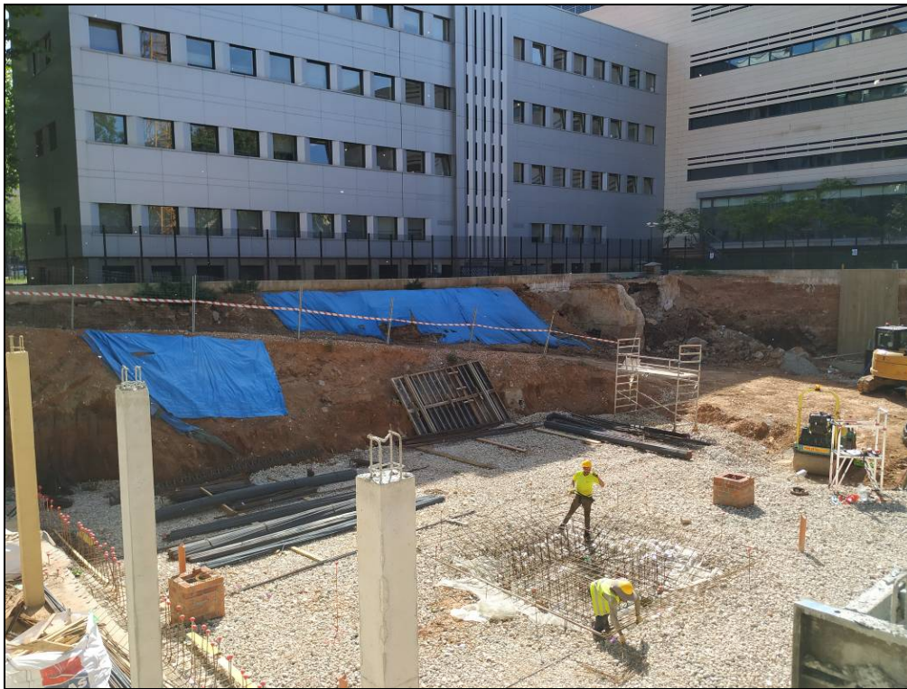
Foto 47: Imatge general del solar amb part dels betatges construïts.
