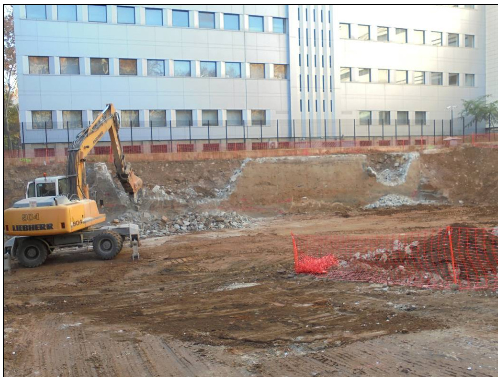
Foto 34: Eliminació del mur de la dècada de 1970 construït de formigó armat.
