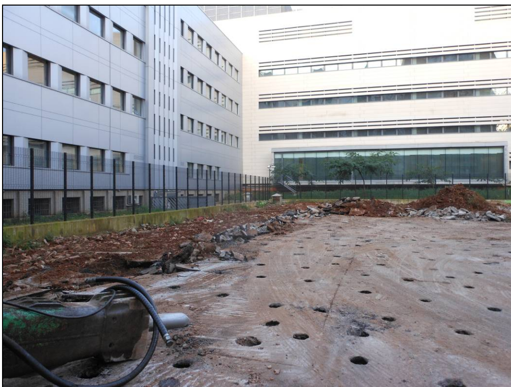
Foto 8: Preparació per a l'extracció del paviment formigó.
