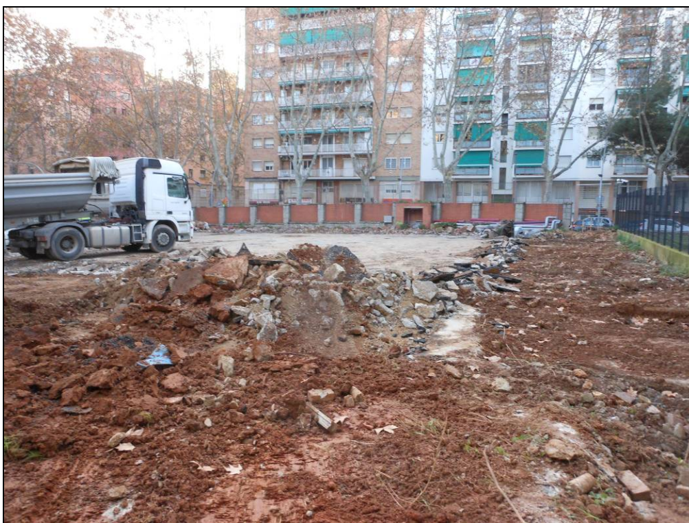
Foto 6: Vista general del solar, d'un sector amb el paviment de formigó extret.
