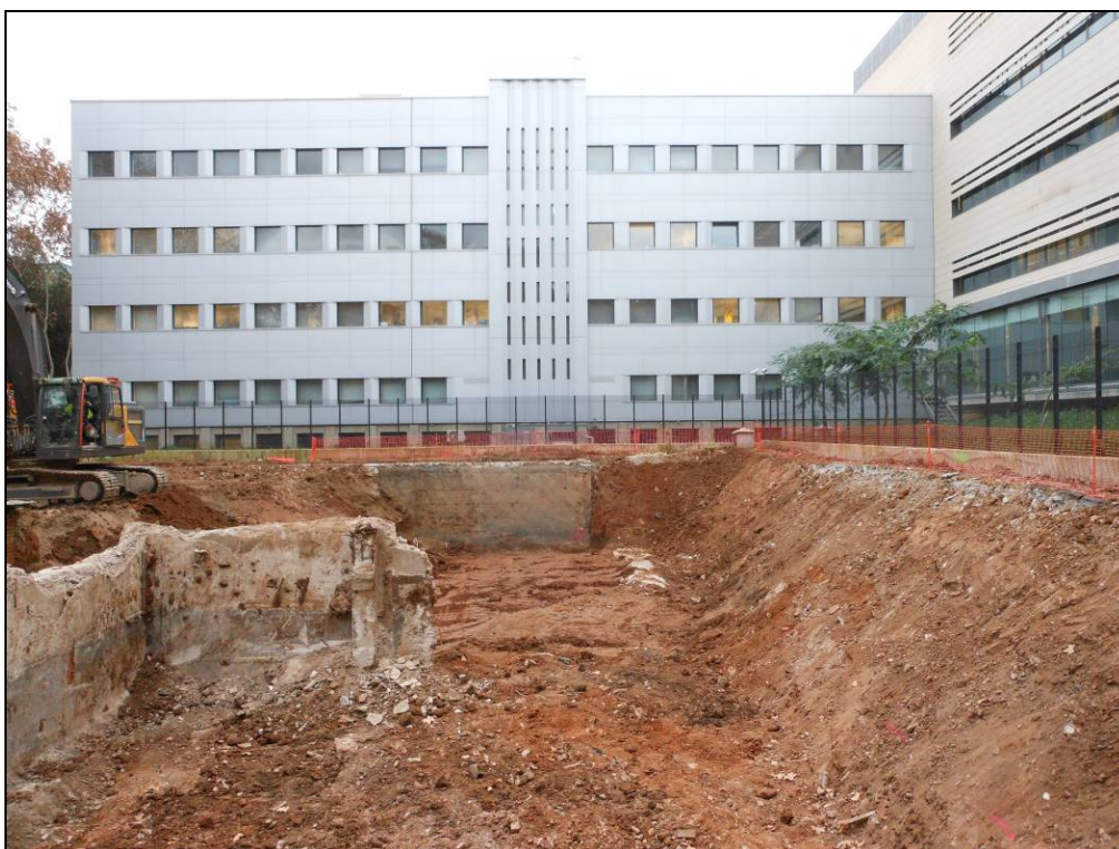
Foto 28: Vista general del talús.
