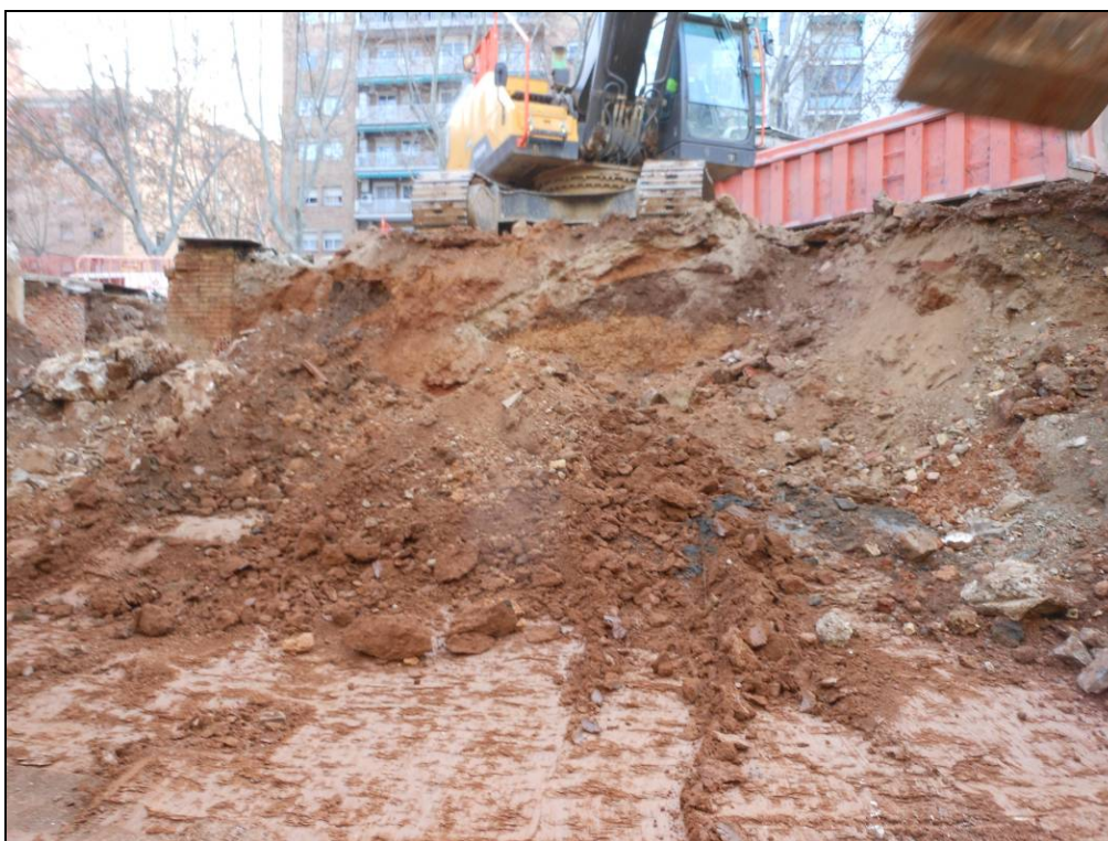
Foto 26: Excavació dels nivells superficials.
