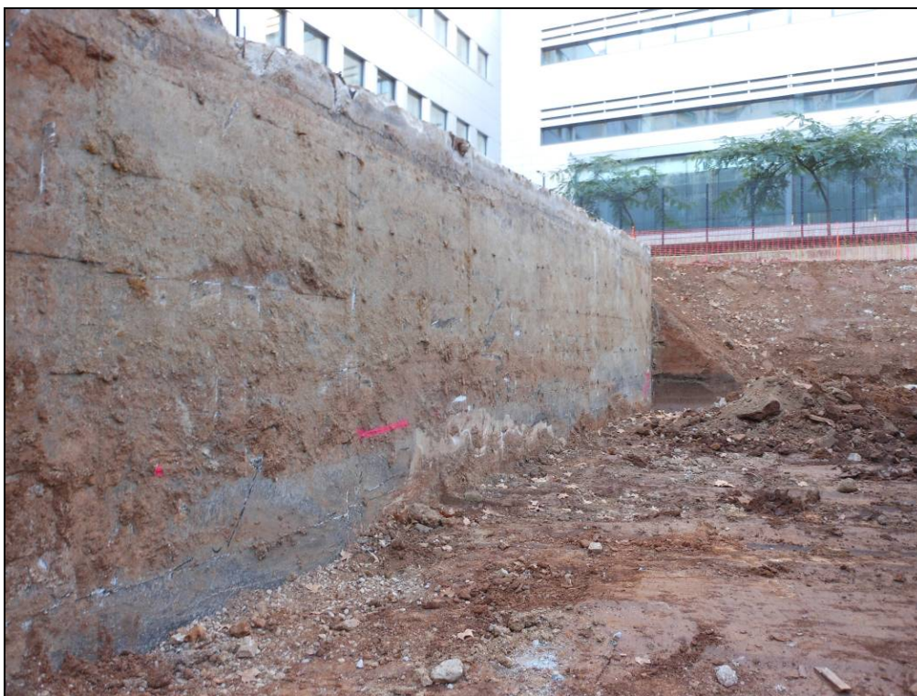
Foto 33: Parament de construcció mitjançant encofrat de la dècada de 1970.
