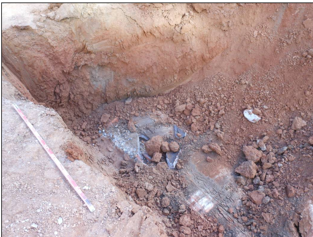
Foto 39: Vista de detall de la canalització de formigó que travessa part del solar.
