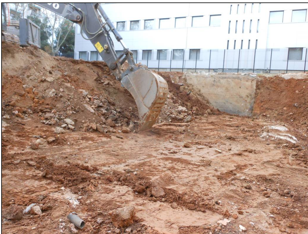
Foto 25: Excavació dels nivells superficials.
