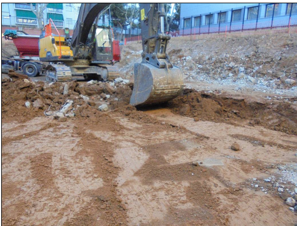
Foto 36: Eliminació de les capes superficials deixant visible part de les argiles quaternàries.
