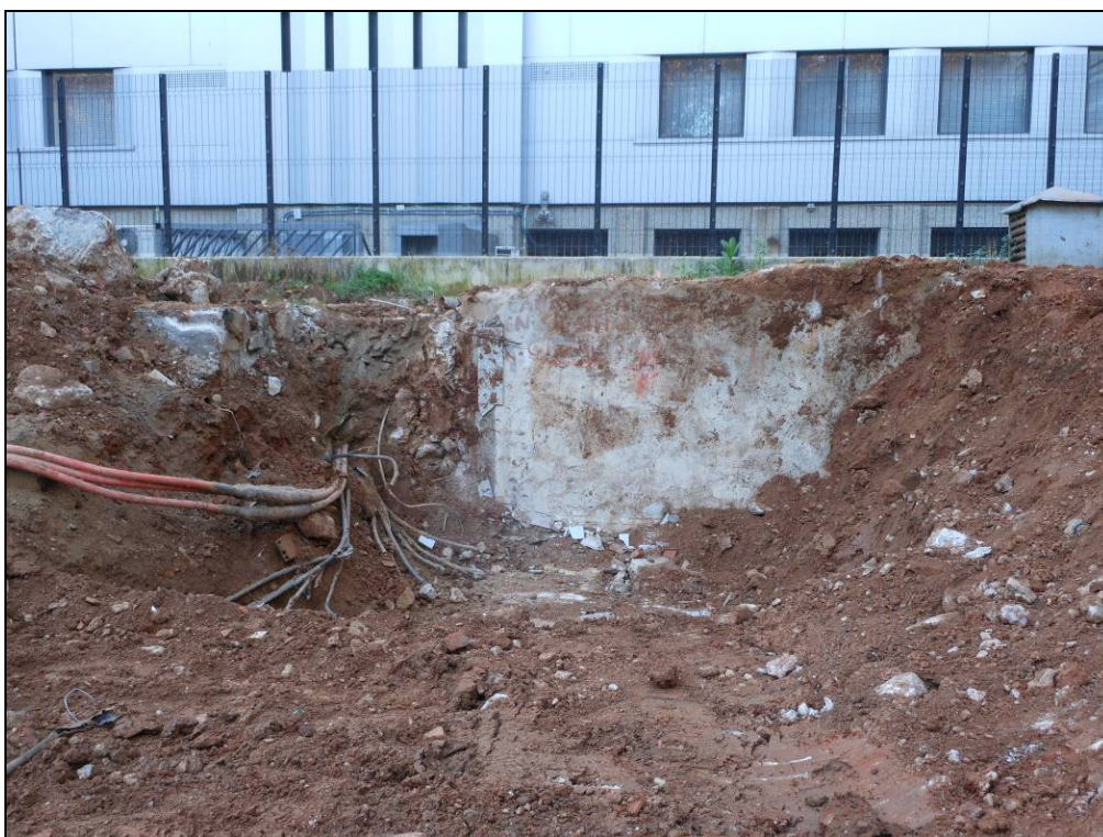
Foto 14: Mur de formigó de la dècada de 1970. Pertanyia a un soterrani.
