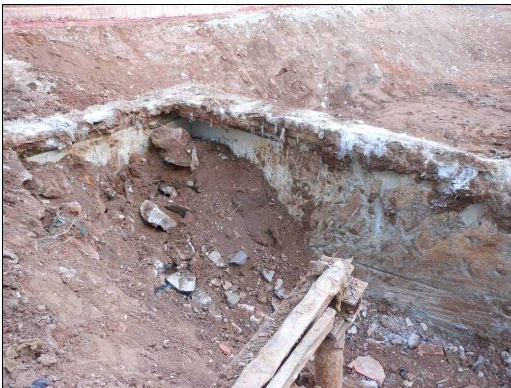
Foto 23: Detall d'una dependència subterrània de la dècada de 1970.
