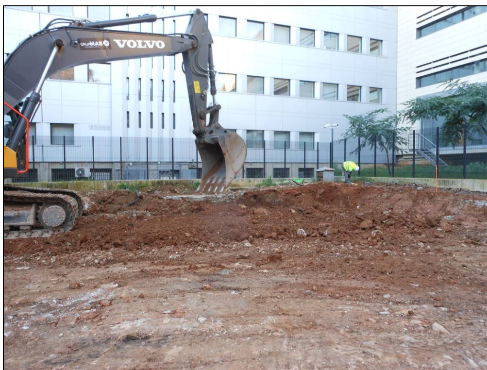
Foto 12: Treballs amb la màquina retroexcavadora tipus giratòria.
