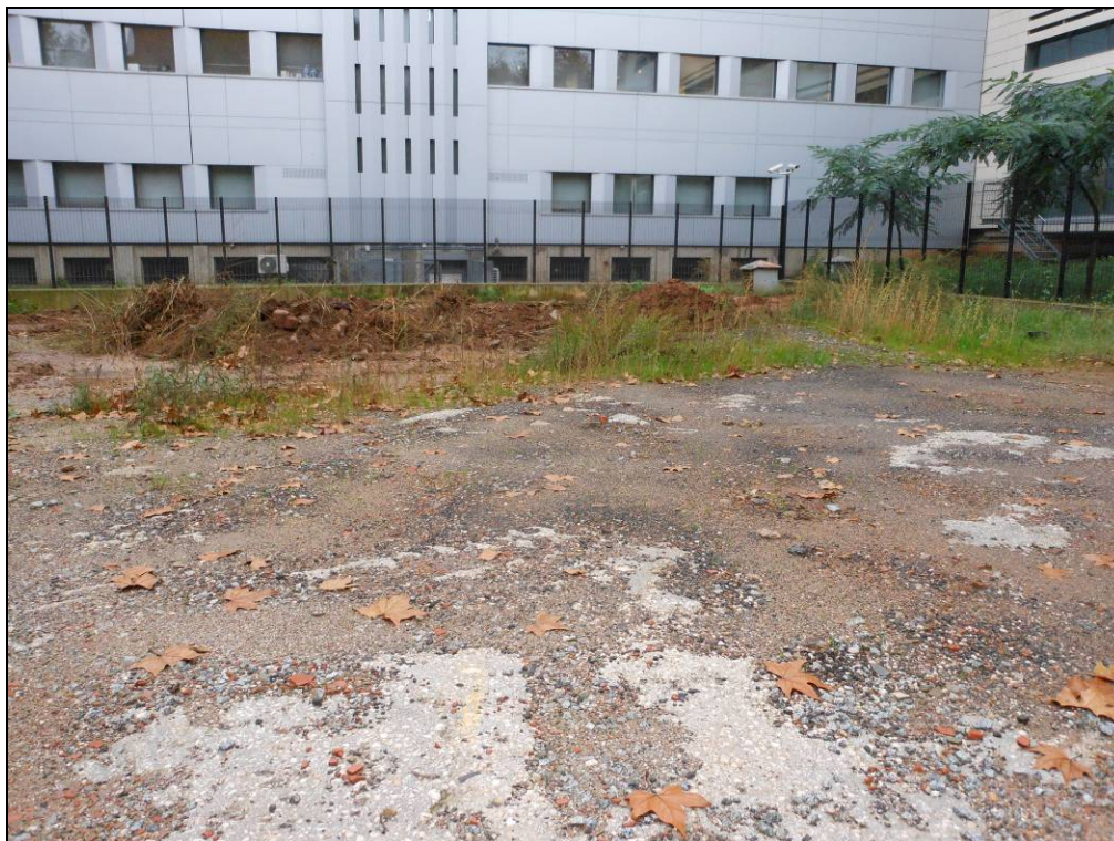
Foto 1: Estat inicial del solar, on presenta una capa de formigó.
