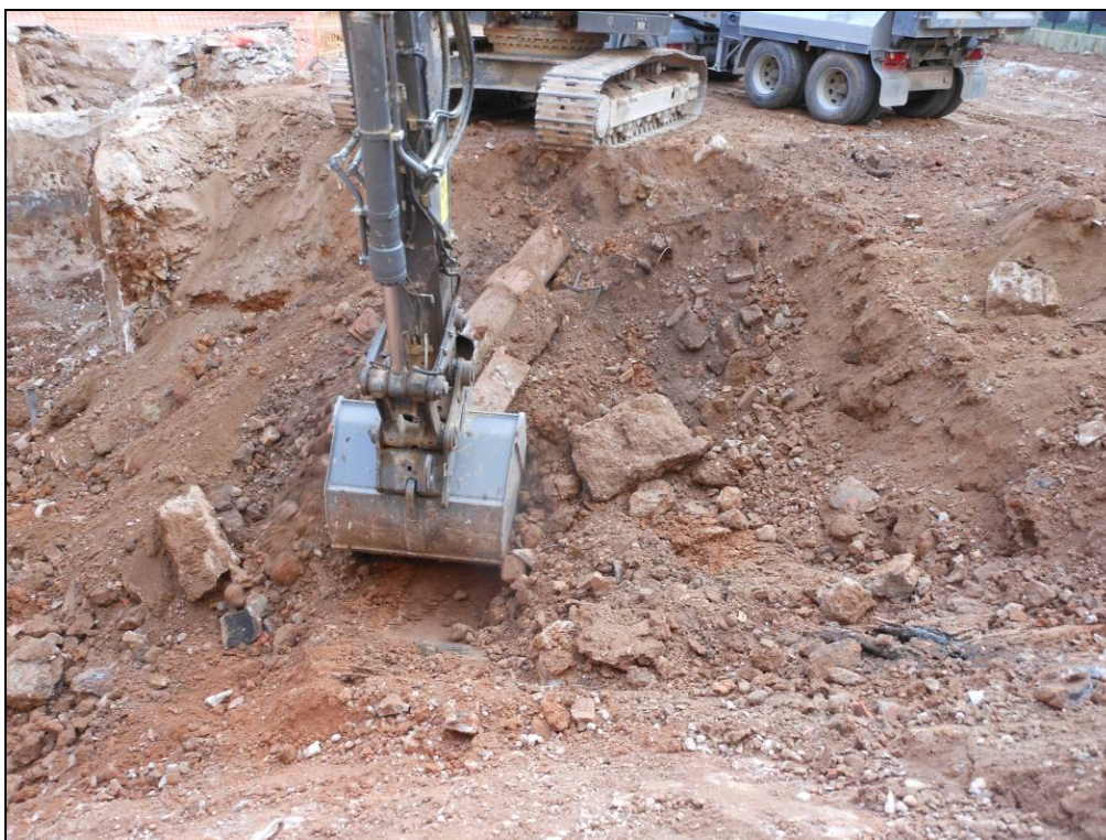
Foto 17: Detall del sediment excavat al solar de la futura biblioteca.
