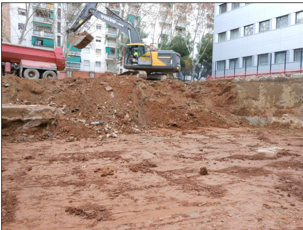
Foto 29: Extracció de sediments d'aportació antròpica.
