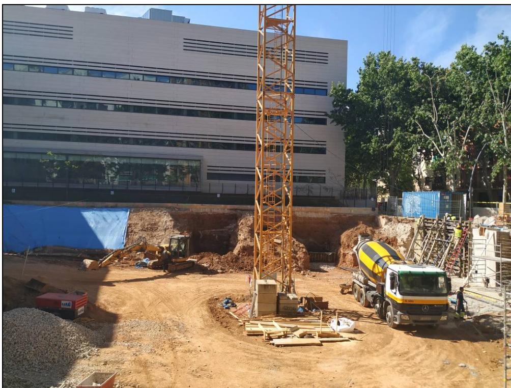
Foto 43: Vista general del solar.
