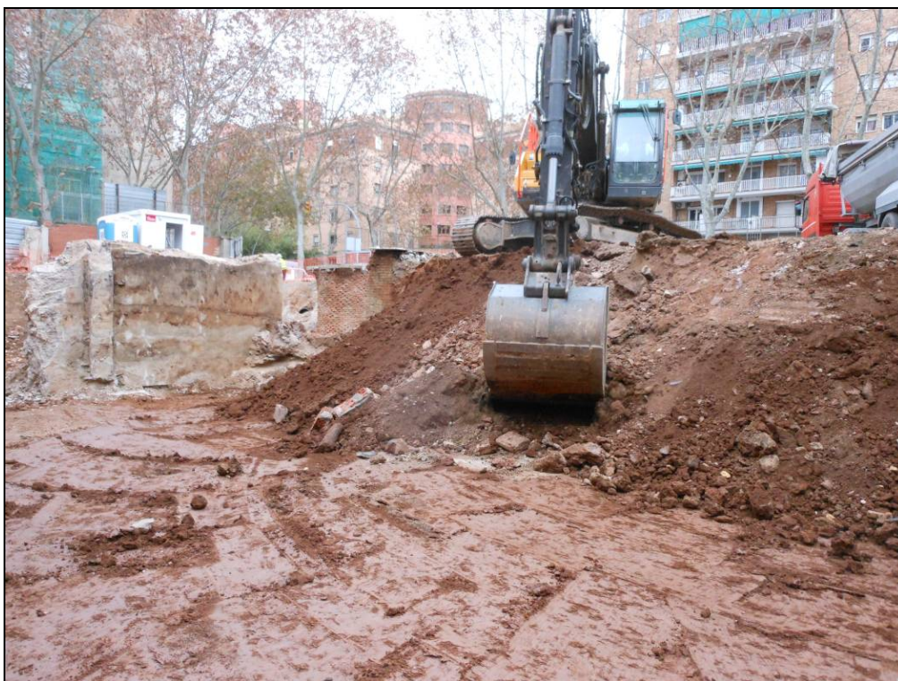
Foto 27: Excavació dels nivells superficials.
