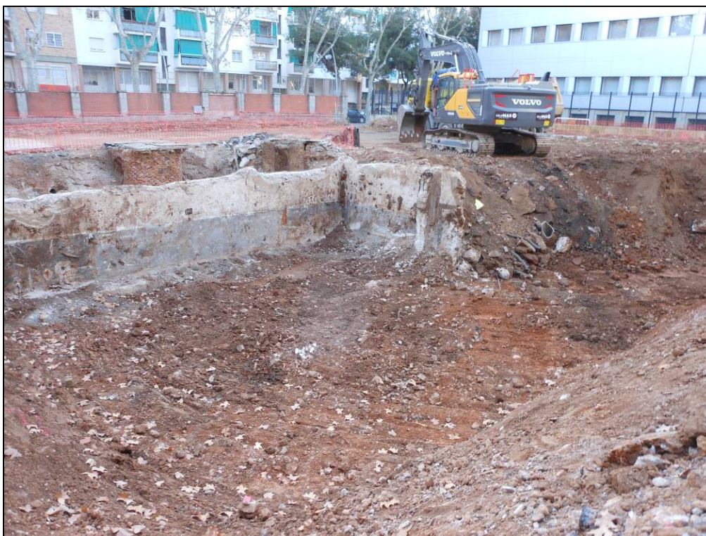
Foto 19: Vista general dels sediments excavats amb murs dels anys 70.
