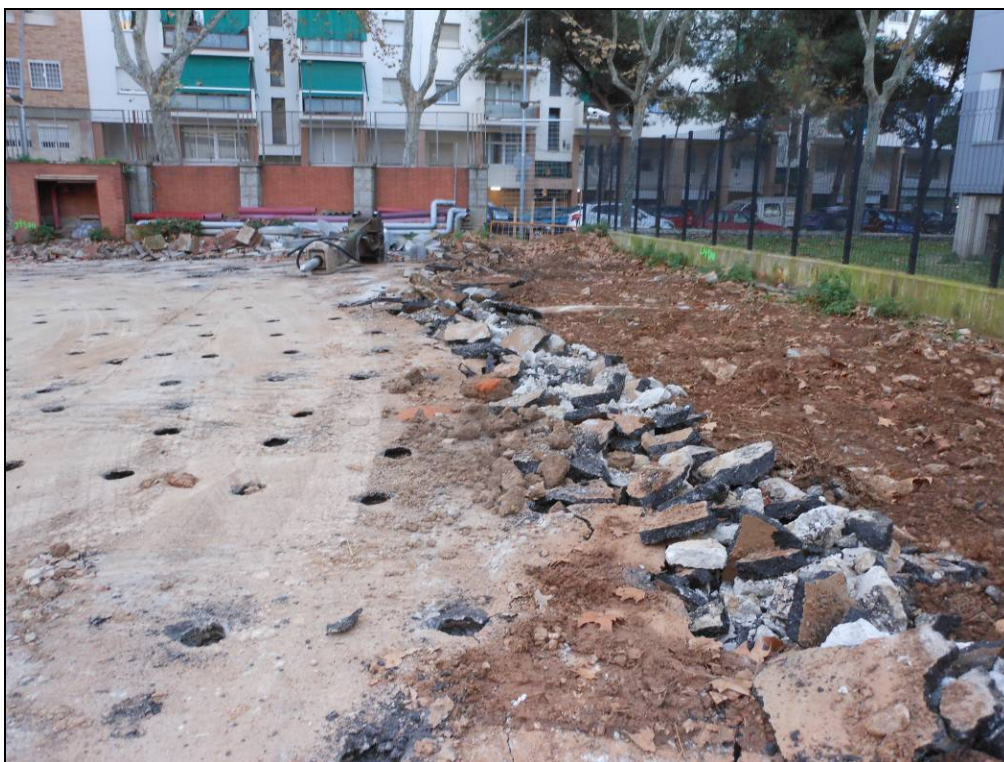
Foto 7: Extracció del paviment de formigó.
