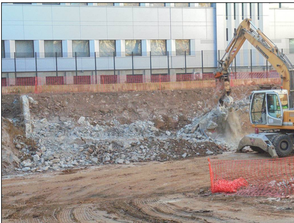
Foto 35: Eliminació del mur de la dècada de 1970 construït de formigó armat.
