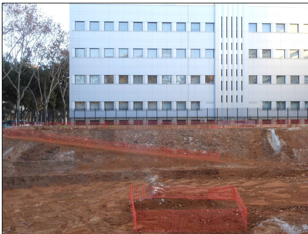
Foto 40: Imatge general de la rampa d'accés.
