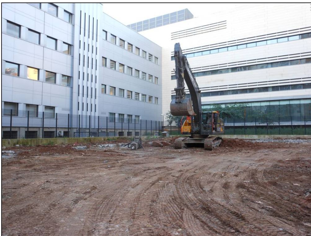
Foto 11: Imatge general del solar amb la màquina retroexcavadora.
