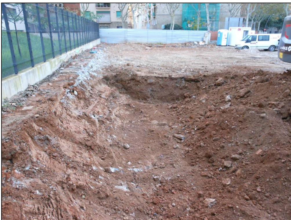
Foto 10: Excavació dels nivells superficials del solar intervingut.
