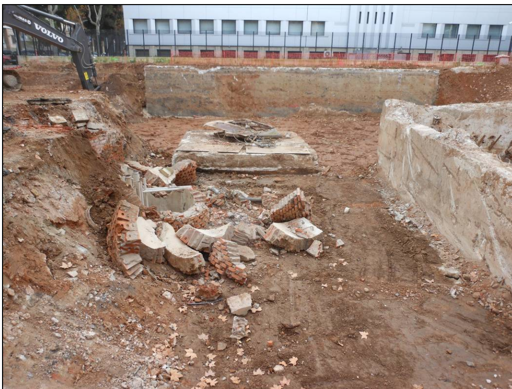
Foto 31: Eliminació d'una part de l'estructura de captació subterrània d'aigües.
