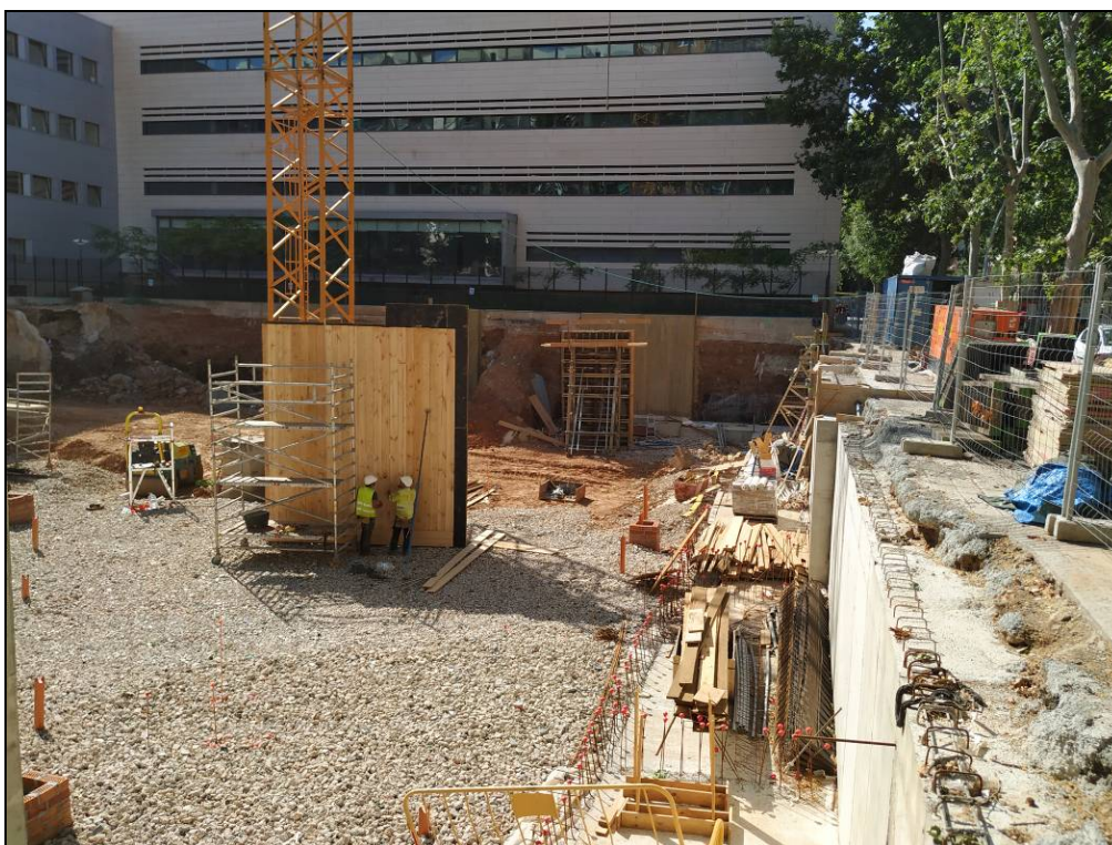
Foto 46: Imatge general del solar amb part dels betatges construïts.
